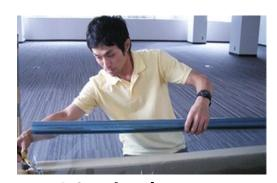
**フィルムのカット** 貼付ける窓ガラスのサイズより少し大き めに、フィルムをカットします。
