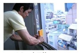
フィルムの本圧着 スキージーやヘラを使用して、フィルム とガラスの間に残っている水分や気泡を 丁寧に外へ押し出します。
