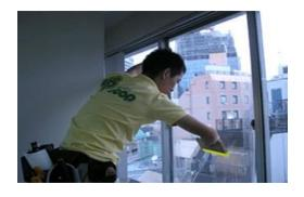
仮貼り付け時、ガラス面とフィルムの貼り付け面にスプレーした溶液が下側に垂れますが、養生シートを敷いていますのでご安心ください。
