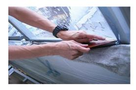
カットの際に、フィルムとコーキングの 間は1~3mm程度の隙間を空けて貼り付 けします。
